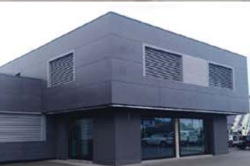
Interventi e finiture d'esterno
